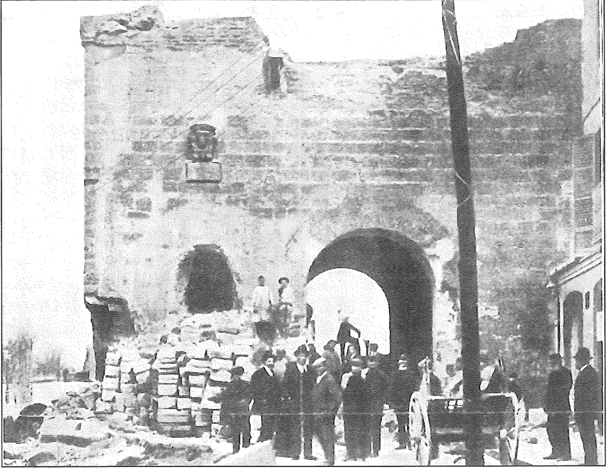
Palma de Mallorca. La puerta de Santa Margarita al comenzar su derribo.
